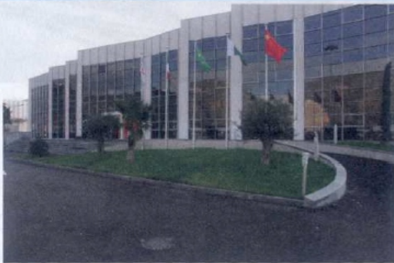
In fase di ultimazione anche le palazzine di Phard e Kuvera
